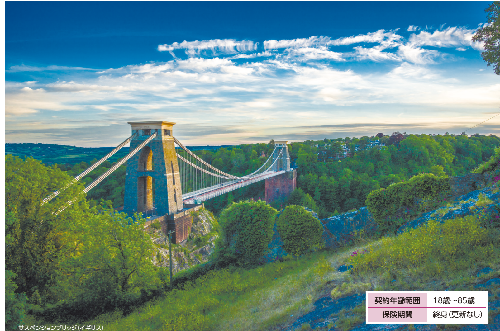
サスペンションブリッジ(イギリス)
